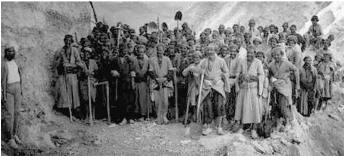
▲ کارگران در آغاز ساخت تونل کندوان: پیدایش کارگران بخش ساخت و ساز دولتی در دوره رضاشاه
